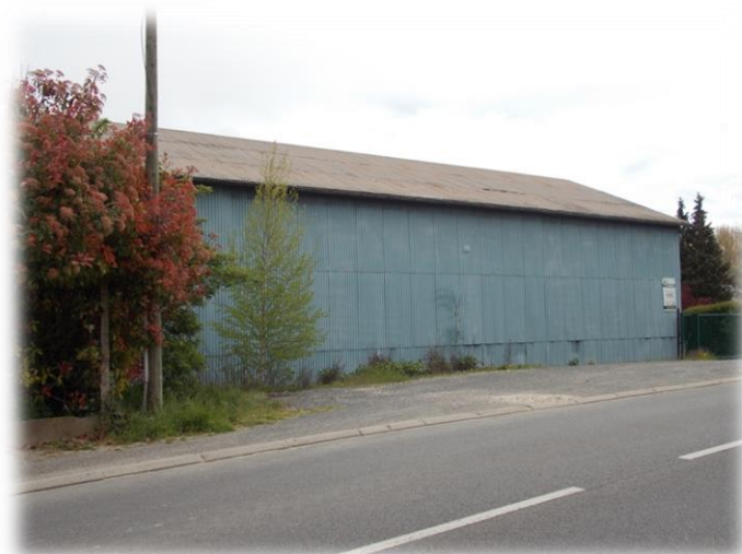
Hangar - Rue de l'Essonne
