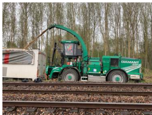
Broyage et chargement des plaquettes sur des semi-remorques
